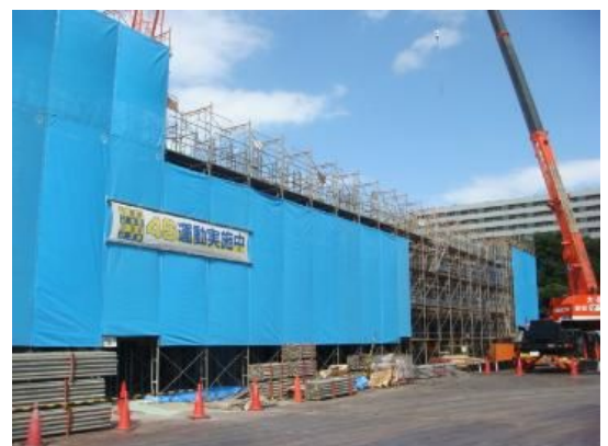
【工事現場の様子】
